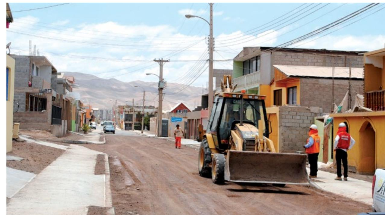
2) Autoconstrucción Sector C-D: Av. Violeta Parra entre Av. Santa María y Juanita Fernández, con una longitud de 249.76 mts. y ancho de 14 mts, con una superficie intervenida de 3,496,64 m2 en asfalto.
